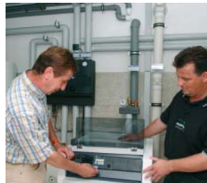
Eine Heizungssanierung dauert normalerweise nur wenige Tage.
