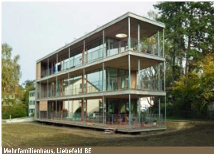
Mehrfamilienhaus, Liebefeld BE
